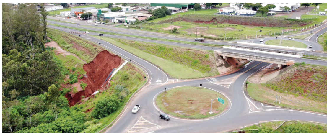
NOVA ESPERANÇA - Na BR-376 altura do KM 137 há dois pontos de erosão que já afetam o tráfego parcial da pista e trevo de acesso à Uniflor. O Deslizamento também provocou a queda de um poste de energia e fez com que o DER interditasse parcialmente o trecho
